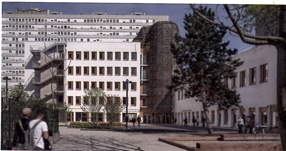
◀ La médiathèque James-Baldwin et la Maison des réfugiés, Paris 19 e . Assemblant un équipement culturel de proximité et un lieu dédié à l'intégration des personnes exilées sur le territoire parisien, le programme présente une haute valeur culturelle et sociale.
