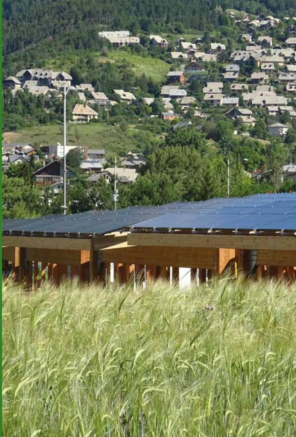
Le projet s'inscrit dans le site de la plateforme de covoiturage de Baratier. Les ombrières se développent sur une portion d'arc de cercle et complètent, avec le point sanitaire précédemment réalisé une figure architecturale affirmée. Les modules supports des panneaux sont réalisés en mélèze local. Les panneaux sont orientés vers le S/SO et survolent les champs d'orge tapissant le terrain en limite.
