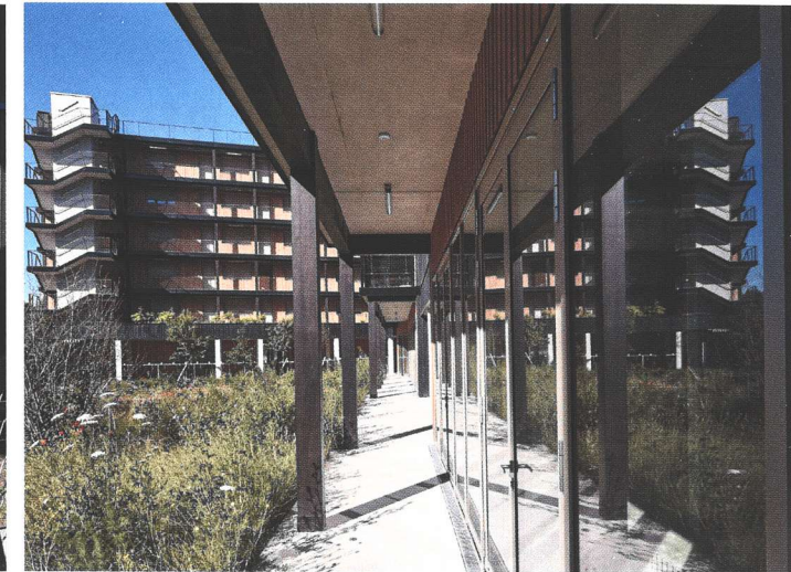
▲ Fluidité des circulations abritées en rez-de-jardin
