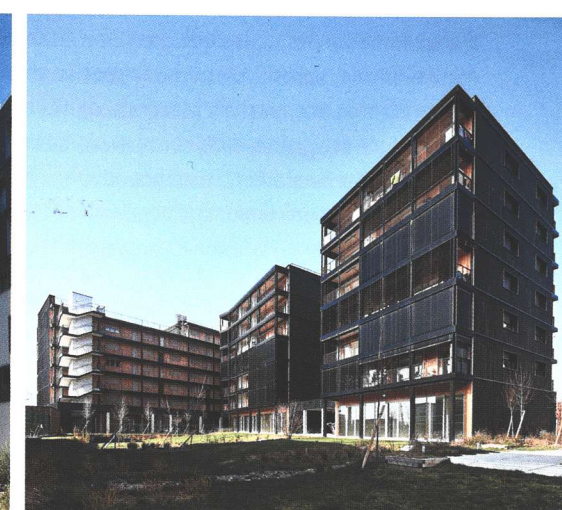
▲ Les circulations verticales prennent place entre les plots dont les pignons sont habillés d'un bardage bois lasuré noir.
