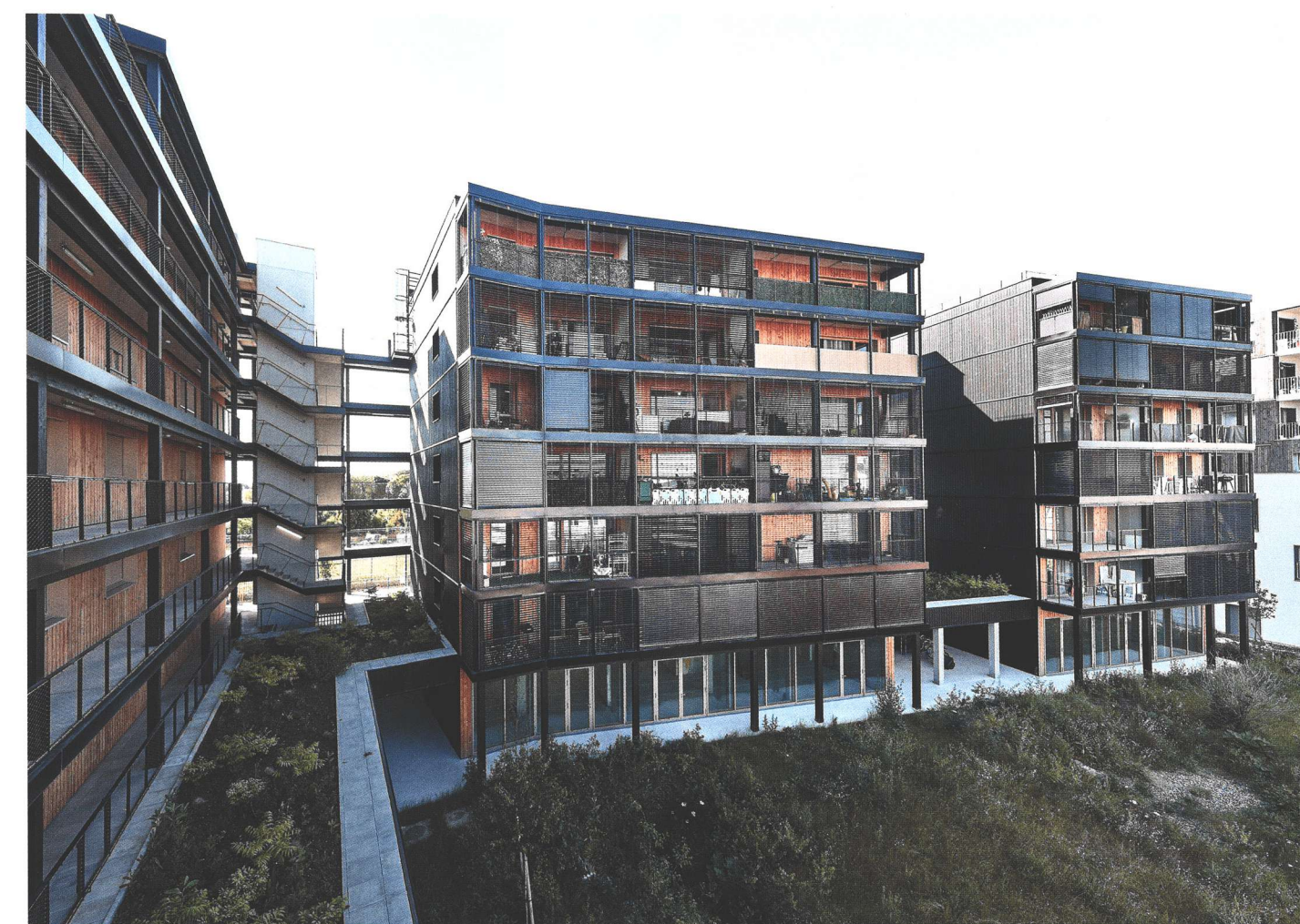
▲ Vue depuis les coursives sur les plots qui bordent la rue Sankara. Les circulations communes sont extérieures.
