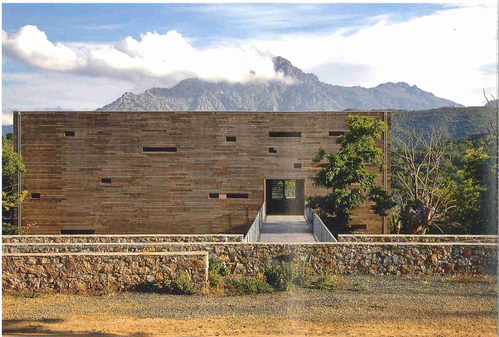
L'accès à la passerelle se fait par un cheminement bordé de murs en pierre locale.
