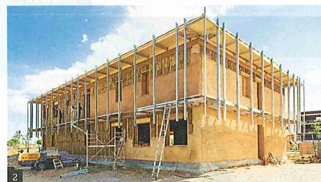
1 - A l'intérieur, une chape anhydrite laissée brute et des enduits de terre crue pour l'inertie. 2 - La terre recouvre aussi la façade en paille.
