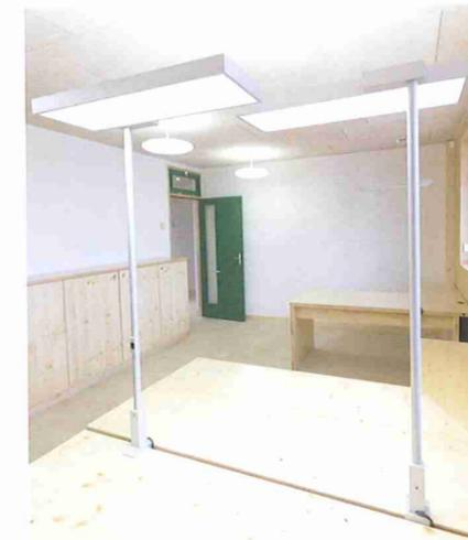
Pour l'éclairage artificiel, les sources et luminaires à haut rendement ont été privilégiés : tubes fluorescents T5 pour les bureaux, salles de réunion et formation, LED pour les circulations et sanitaires, lampes fluocompactes pour les pièces de stockage.
