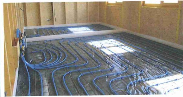
Le chauffage et le rafraîchissement sont assurés par un plancher chauffant/rafraîchissant alimenté par une pompe à chaleur sur pieux géothermiques.
