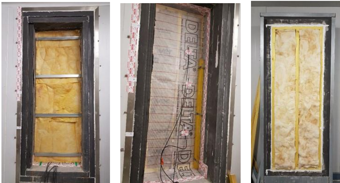
Figure 36 : Mise en œuvre de la configuration 6 (comble perdu)
