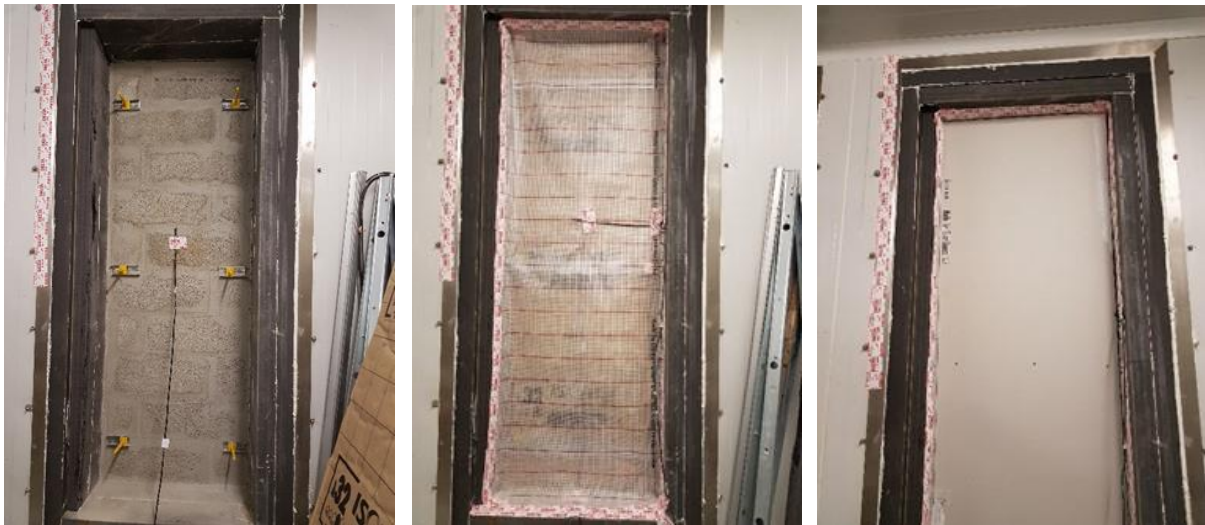
Figure 29 : Mise en œuvre de la configuration 4 (paroi en maçonnerie)
