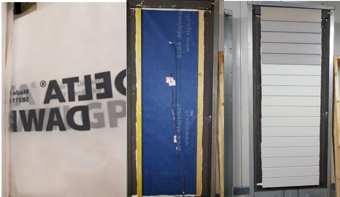
Figure 35 : Mise en œuvre de la configuration 5 (paroi ossature bois)
