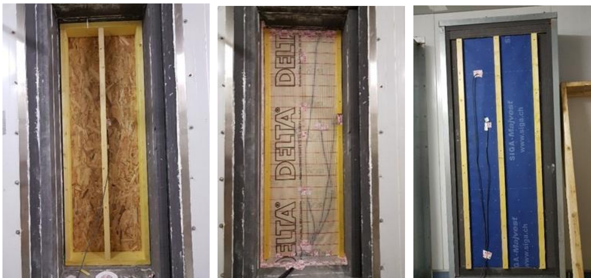
Figure 28 : Mise en œuvre de la configuration 3 (mur ossature bois)
