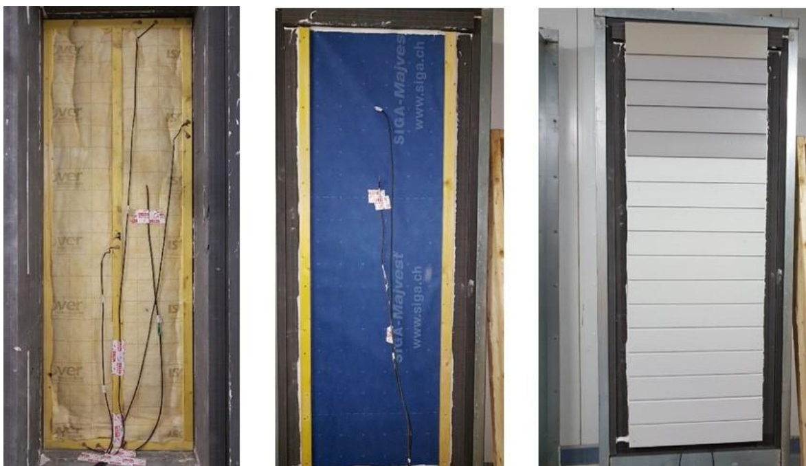
Figure 44 : Mise en œuvre de la configuration 8 (paroi ossature bois)
