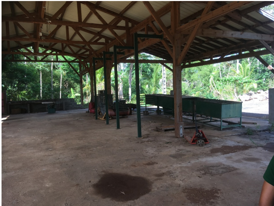
Photo n°1 - Hangar en bois couvert - Ancien bain de traitement des bois
