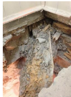
Plancher de sanitaires d'un lycée
