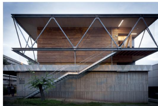
▲ La surélévation est bardée de mélèze et ceinturée par une poutre treillis métallique.
