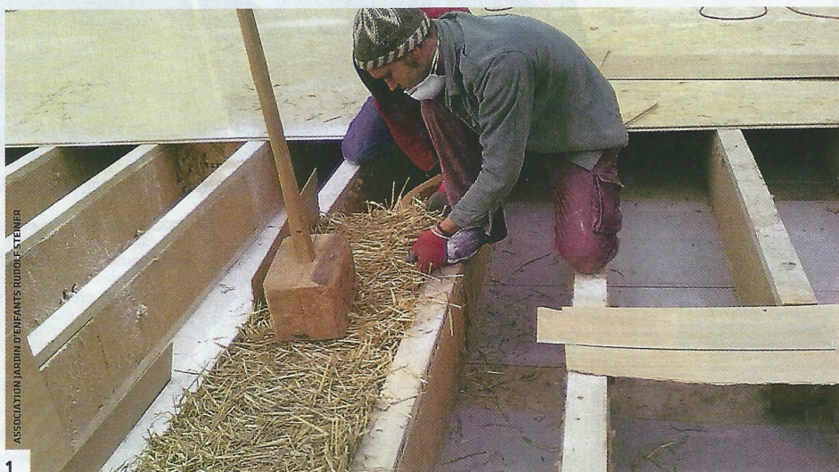
1. Les ballots sont compressés, puis mis en caissons sur le chantier.
