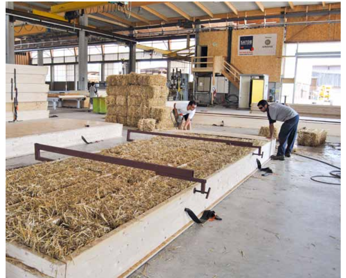
Paille en bottes Les quelque 6 000 bottes de paille qui isolent ce bâtiment ont été produites dans la région toulousaine, tout près de l'usine du constructeur SATOB.
