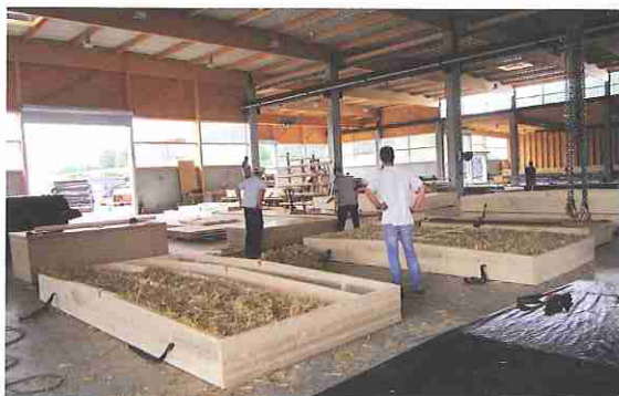
▲ Fabrication des panneaux de façade.
