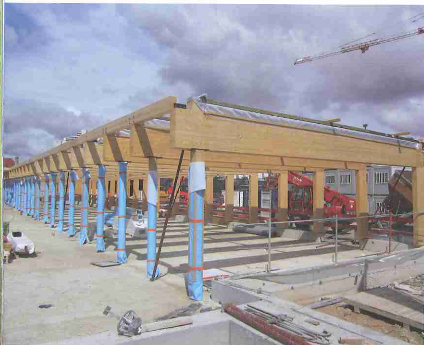
▲ Charpente du rez-de-chaussée.
