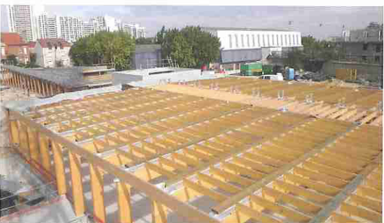
▲ Réalisation de la toiture de l'école maternelle, support de la cour de récréation de l'école primaire.
