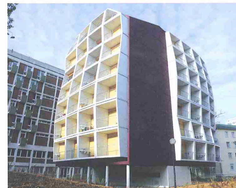
Le troisième bloc de chambres est orienté à l'est. Ouvert sur l'extérieur, le rez-de-jardin intègre les salles de réunion et les services communs.
