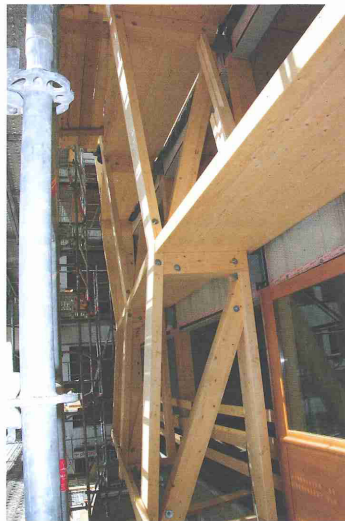
Photo de chantier montrant la structure des balcons sur deux niveaux.
