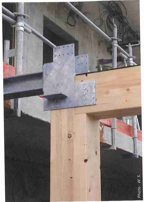
▲ Liaison entre le noyau central en béton et la structure en bois.
