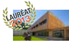
Extension-restructuration du lycée Alexandra David Neel p. 272
