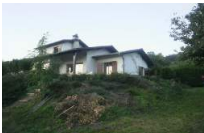
La maison avant travaux.
